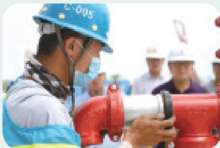
管道安装技能组
